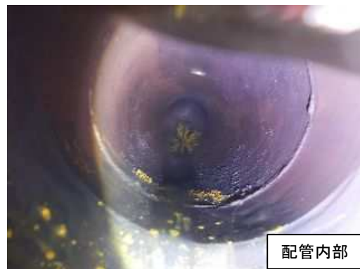
⑩-3 水位制御弁 2次側配管内部
