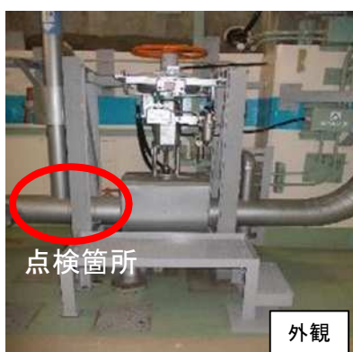
⑩-3 水位制御弁 2次側配管内部
