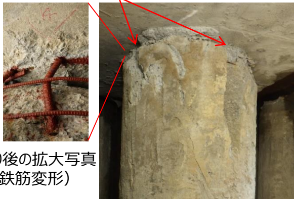
図28 No.8杭の杭頭部の損傷状況
