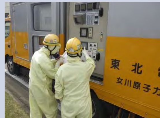
電源車非常停止後の状態確認
