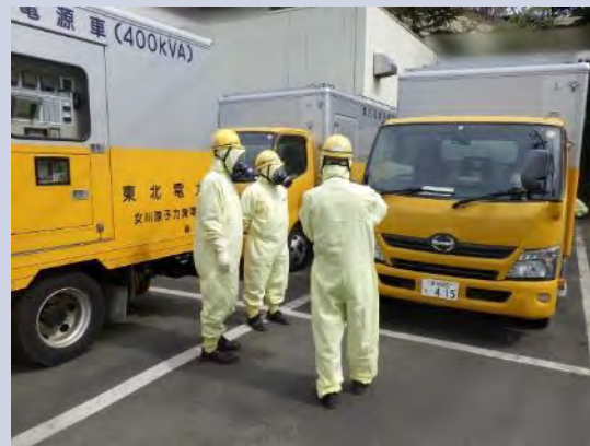
高圧発電機車始動前点検
