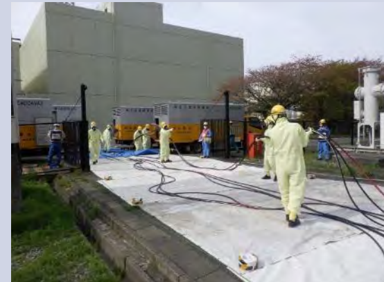
ケーブル敷設
