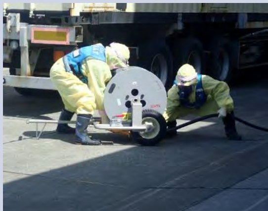
ケーブル敷設
