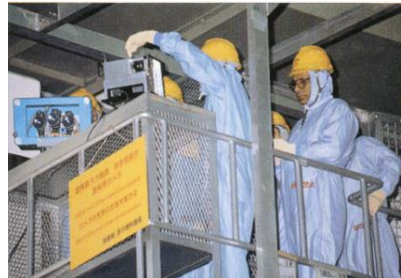
監視装置の保守管理
