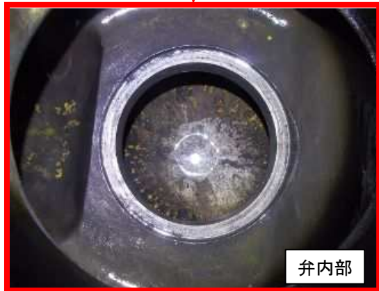
⑩-2 水位制御弁 1次側配管内部
