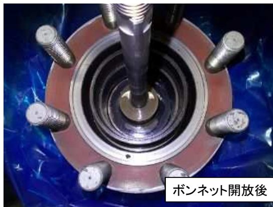
⑩-2 水位制御弁 1次側配管内部
