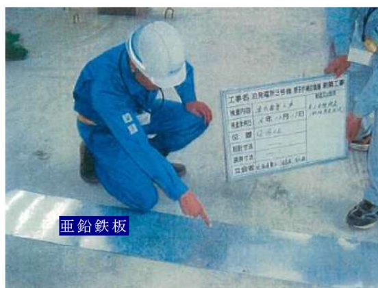
別紙 10-16 図 集水管敷設状況写真（泊 3 号炉建設時）
