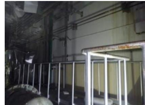
4階プール壁西面（写真）
