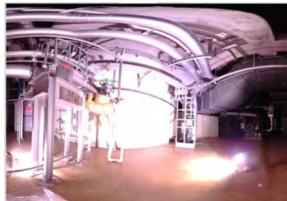
3階シェル壁北東面（写真）
