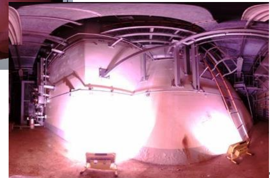
写真：2号機R/B2階シェル壁
