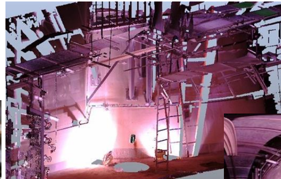
点群：2号機R/B2階シェル壁
