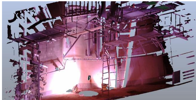
2階シェル壁東面（点群データ）
