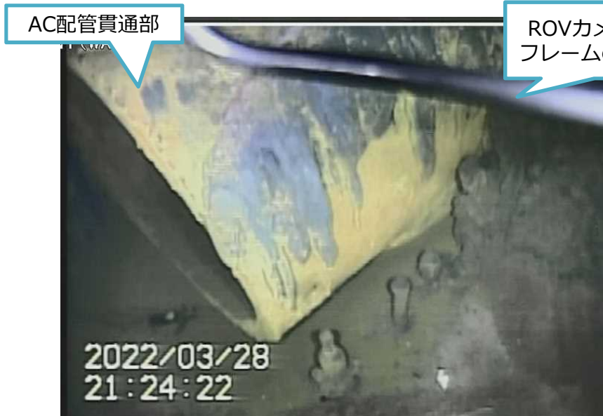
写真2.AC配管貫通部の状況
