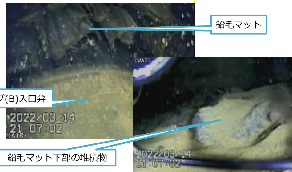
写真3. PLRポンプ(B)入口弁付近の状況
