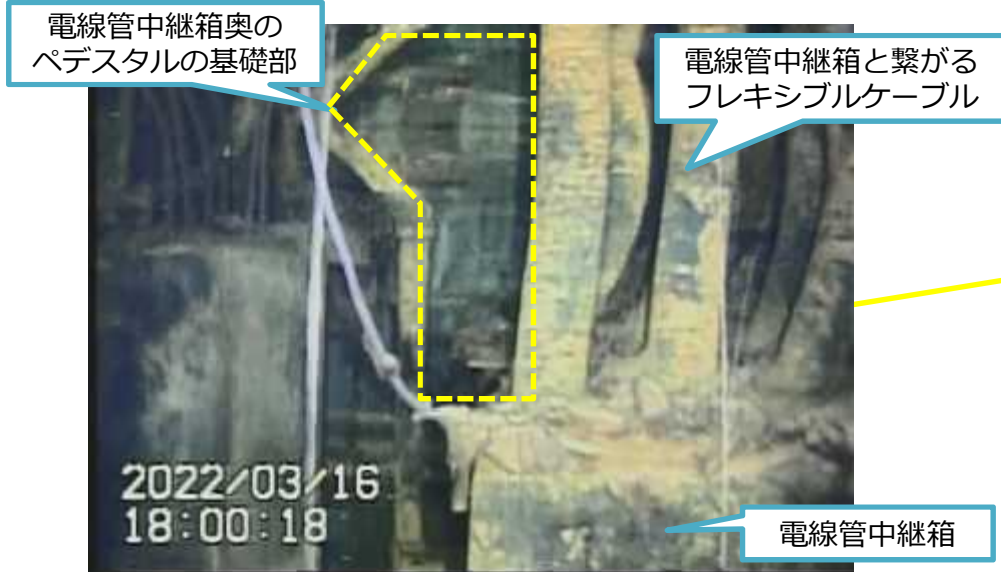
写真1.ペDESTAL基礎部付近の状況①
