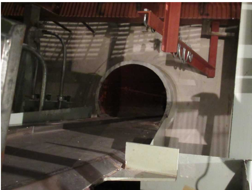
CRD搬入口入口
