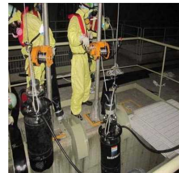
取水用水中ポンプの設置訓練
