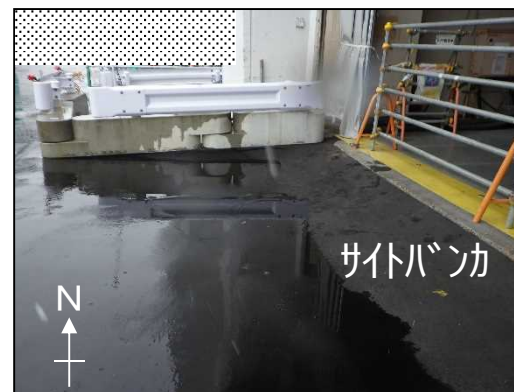
サイトバンク建屋大物搬入口状況
