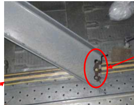
接合部のボルトが破断
