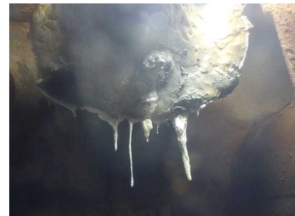
止水により地下水流入停止
