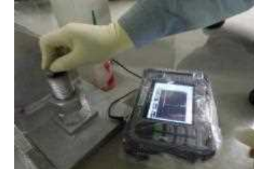
ID1基礎ボルトUT状況
