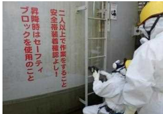
タンク高さの測定
