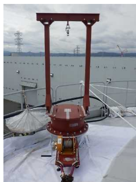
攪拌機器の 設置状況
