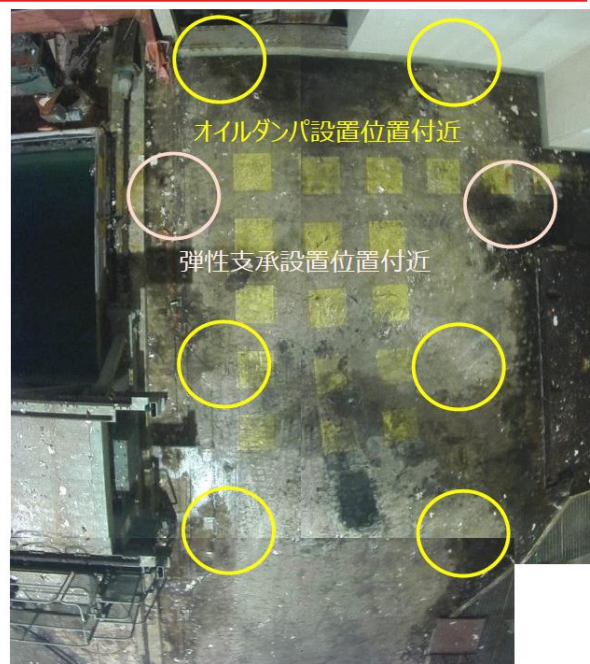
原子炉建屋天井監視カメラにより遠隔撮影した合成写真 (2021/4/15)
