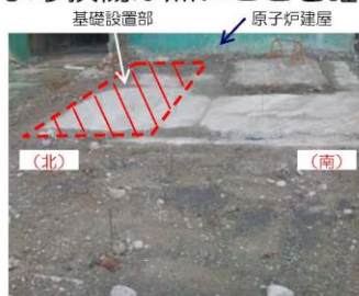
③基礎設置部 (西側)
