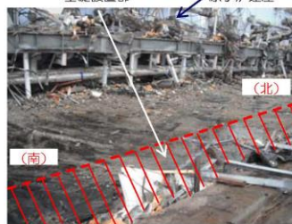
④基礎設置部 (東側、外部)
