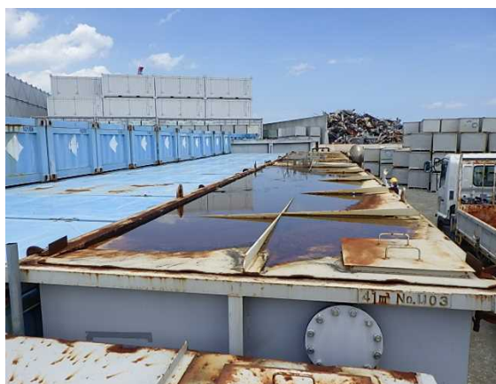
当該ノッチタンク（南側）天板（7月6日撮影）
