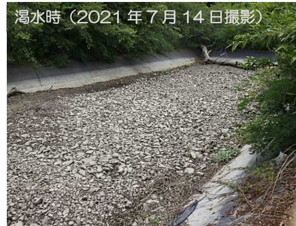
沈砂池全景（写真）
