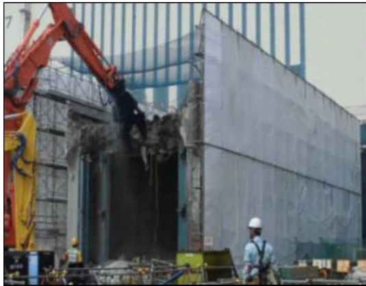
上物解体状況
