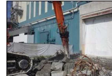
基礎解体状況
