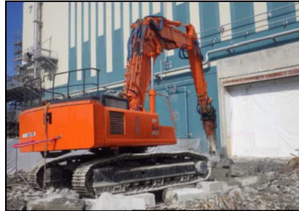
基礎解体状況
