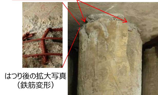
No.8杭の杭頭部の損傷状況 杭頭部がせん断により損傷
