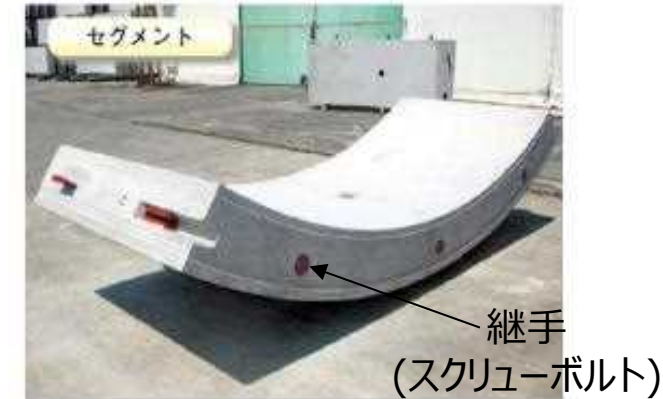
延長方向の継手(スクリーボルト)
