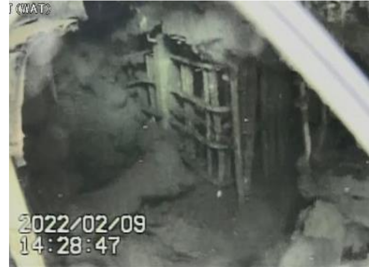
A. ペDESTAL開口部付近
