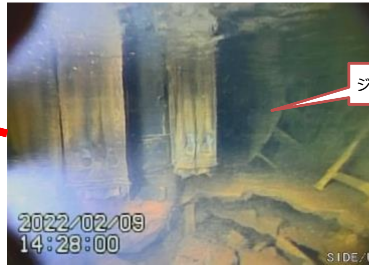
PCV東北東付近の状況(俯瞰)
