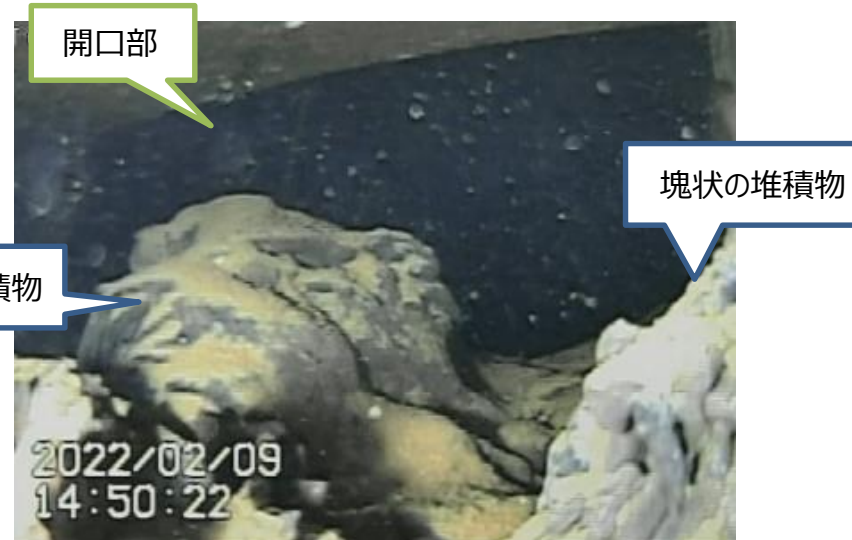
C. ペDESTAL開口部内部
