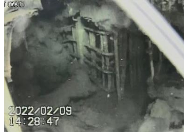
A. ペDESTAL開口部付近
