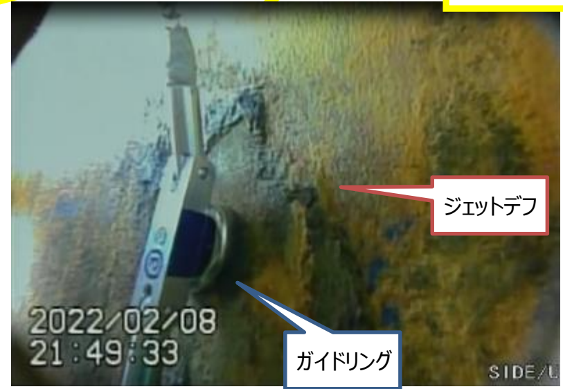
ガイドリング③設置状況 (2月8日午後9時49分設置完了)
