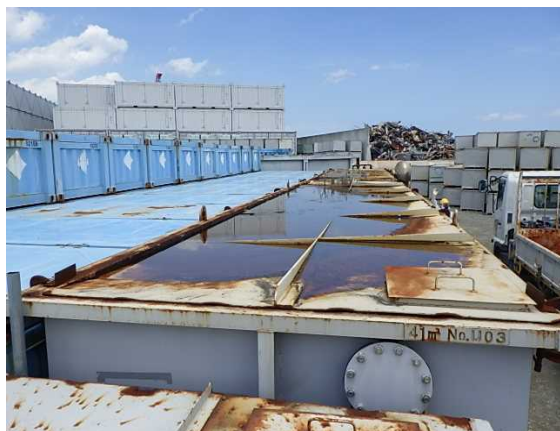
当該ノッチタンク（南側）天板のハッチ蓋（7月7日撮影）
