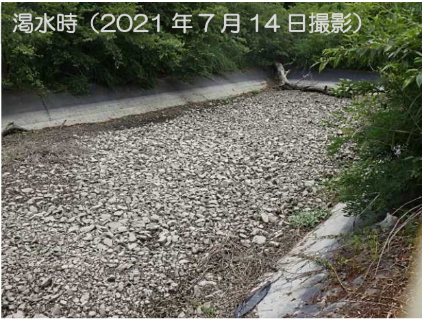
沈砂池全景（写真）
