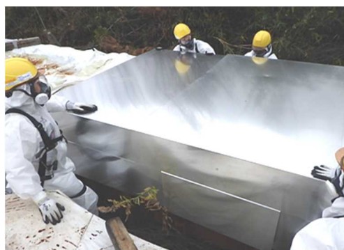
金属製力バー設置状況
