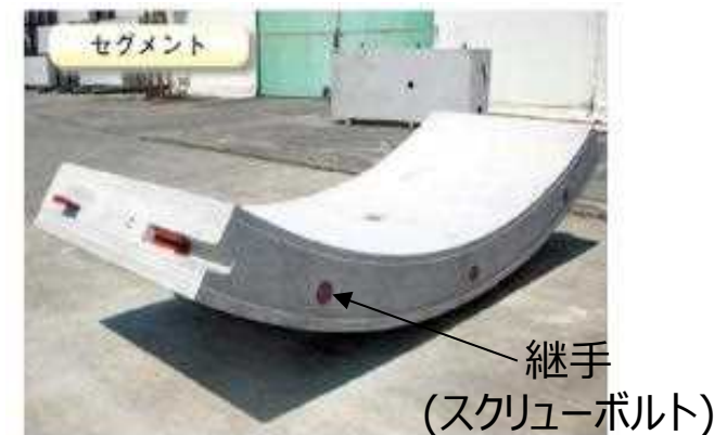
延長方向の継手 (スクリューボルト)
