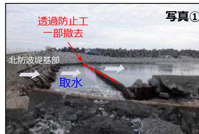
透過防止工撤去イメージ図
