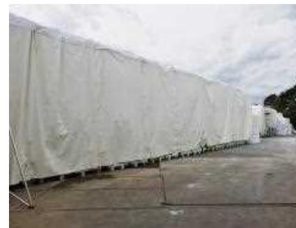
仮設シート養生については、より耐候性の高い本設シート養生へのリプレースを実施中
