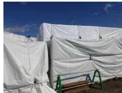
雨水の侵入を防止するため、仮設シート養生を実施
