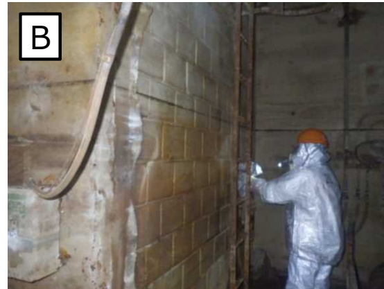
地下1階内壁面B
