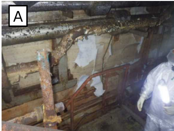
地下1階内壁面A
