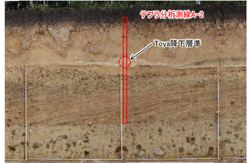
法面④詳細画像
