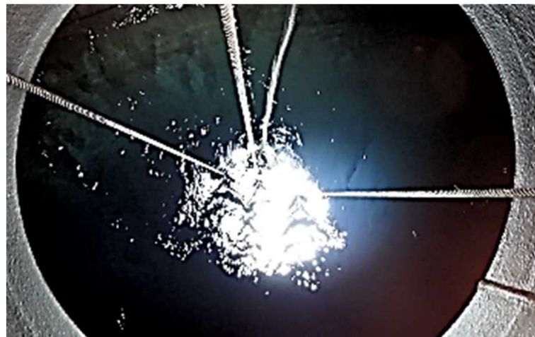
攪拌機器運転時のタンク水面（T/R時に撮影）
