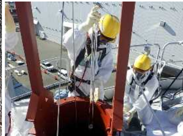
攪拌実証試験当日の採水の様子
