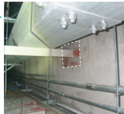
埋込金物 （天井裏 作業エリアから 4m程度上部に存在）
