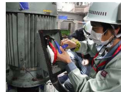
電動機結線作業
