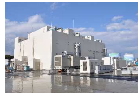
川内 緊急時対策棟 外観
