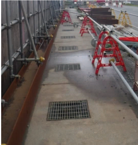
北側幹排水路（写真1）
