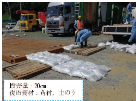
段差復旧作業状況
