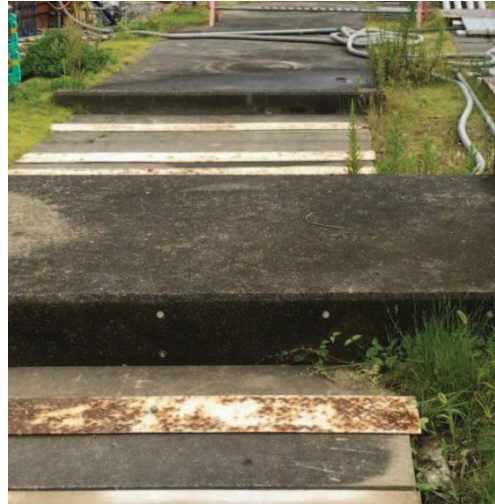
南側幹線排水路（写真2）
