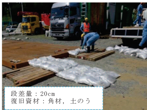
段差復旧作業状況
