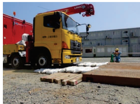
大型車両通行状況
