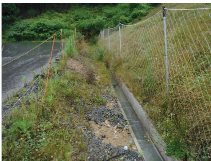
図 5-2 斜面 B の表面排水溝の状況
