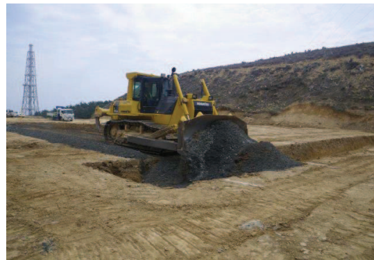
写真2 碎石運搬・埋め戻し・転圧状況
