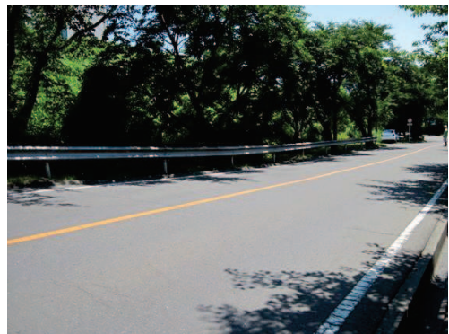
状況写真①
