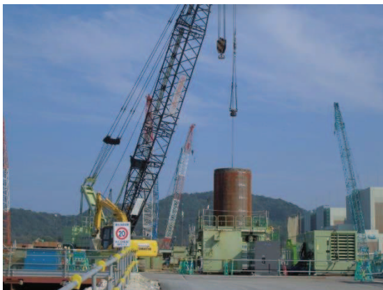
(オールケーシング工法による掘削)
