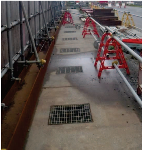
北側幹線排水路（写真1）
