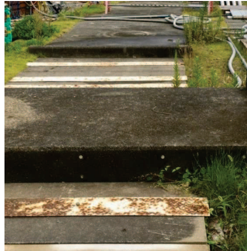
南側幹線排水路（写真2）
