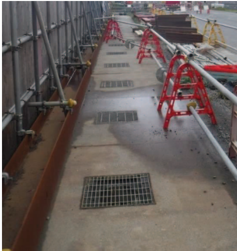
北側幹線排水路（写真1）
