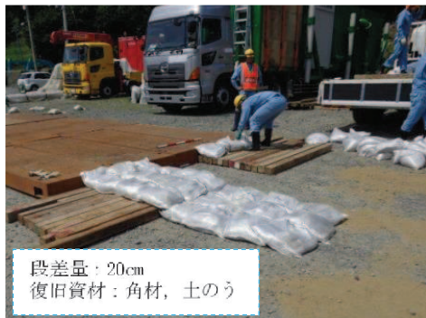
段差復旧作業状況
