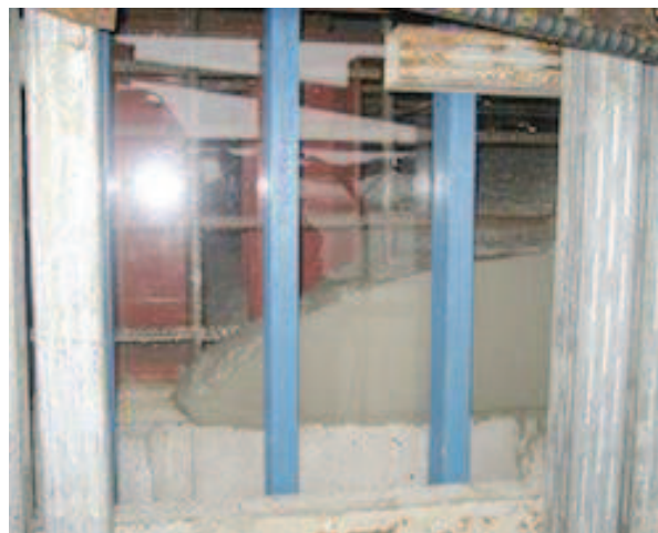
図 5-9 透明アクリル板を型枠に用いた施工の概要 ( http://www.kouyou-shokai.co.jp/mieruform/ より参照)
