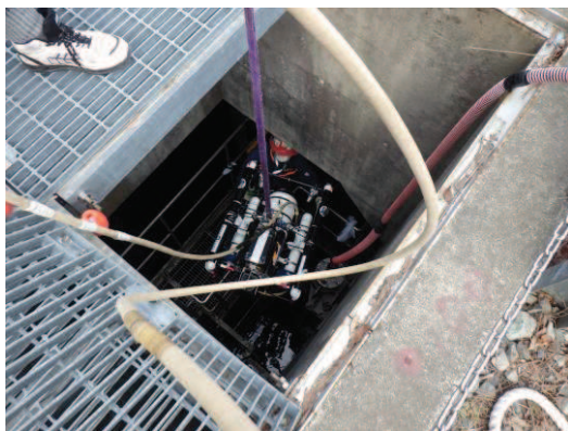
水中カメラを放水路内に投入
