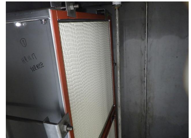
フィルタトレイン内部の様子 (例：3号機A系のHEPAフィルタ)
