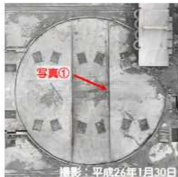
除染作業(小がれき集積)進捗後
