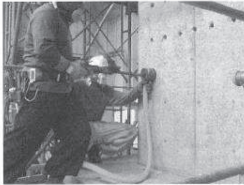
レッグハンマーによる削孔
