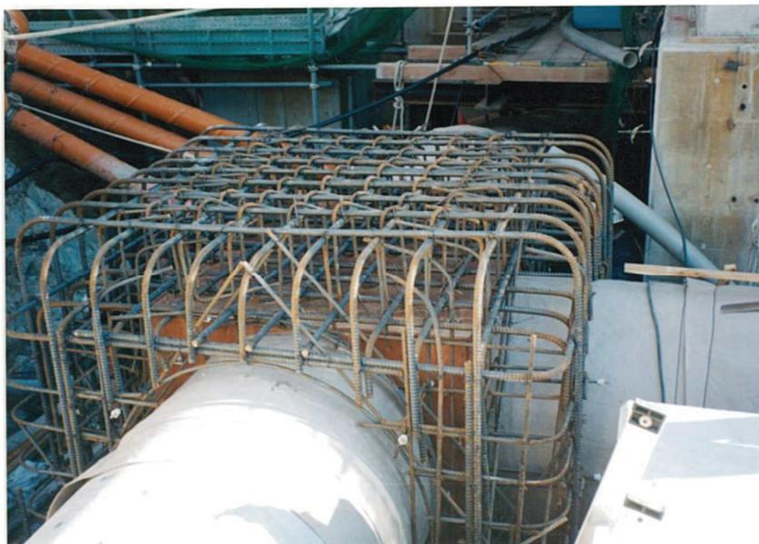
図 3-9 接続柵 (D-3) の配筋図 (上) 及び配筋状況 (下)
