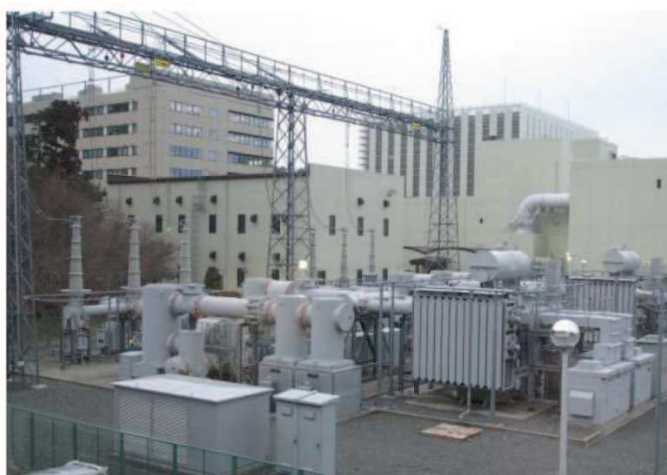
(ガス絶縁開閉装置イメージ)
