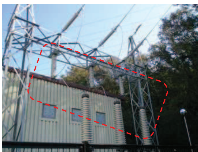
66kV 送電線引込み部（イメージ）
