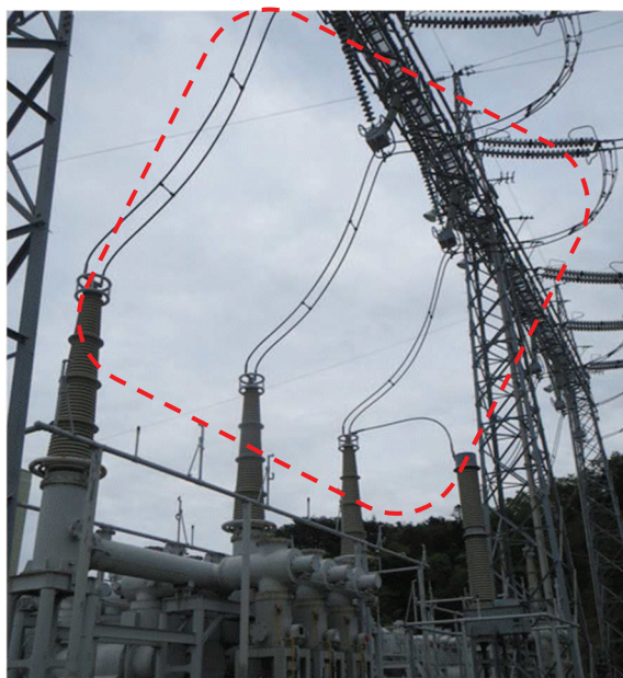
275kV 送電線引込み部（イメージ）
