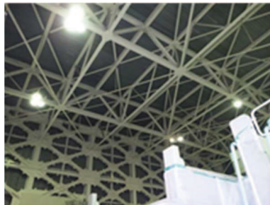
③原子炉建屋原子炉棟 3 階天井
