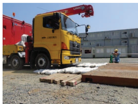
大型車両通行状況
