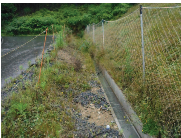
図 5-2 斜面 B の表面排水溝の状況
