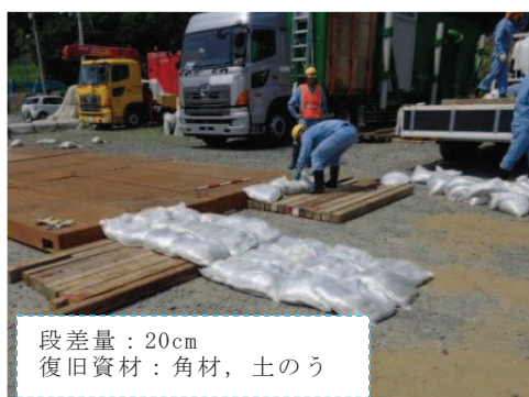
段差復旧作業状況
