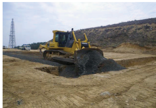
写真2 碎石運搬・埋め戻し・転圧状況
