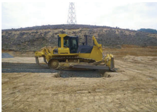
写真3 碎石運搬・埋め戻し・転圧状況
