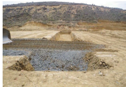
写真4 作業完了状況
