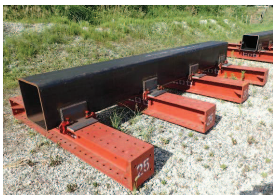
写真1 模擬建屋構造材設置
