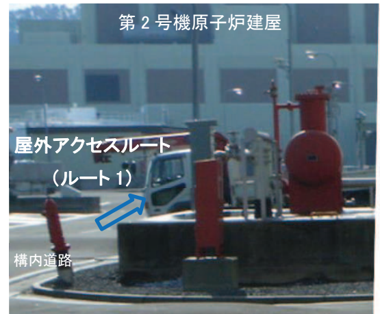
写真 C:地震後の状況【平成 23 年 3 月 12 日撮影】
