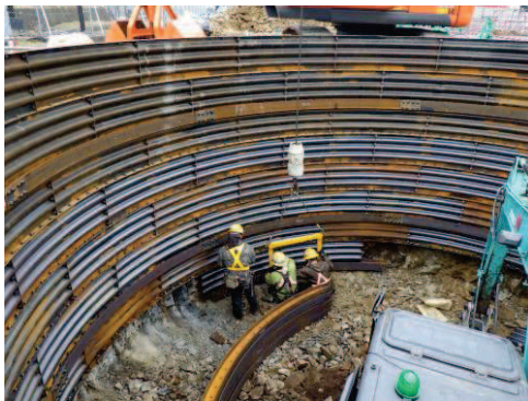
土砂部ライナープレート取付け
