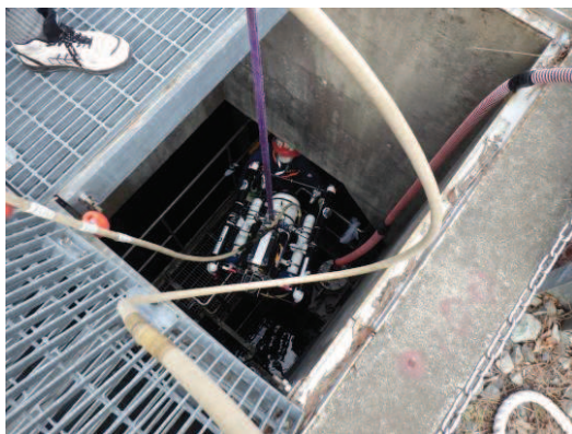
水中カメラを放水路内に投入
