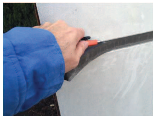
シリコーン材の切り取り状況
