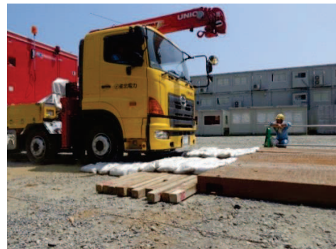
大型車両通行状況
