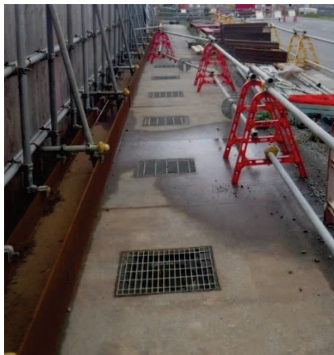
北側幹線排水路 (写真1)
