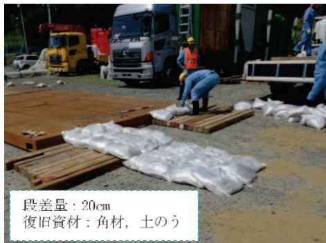
段差復旧作業状況
