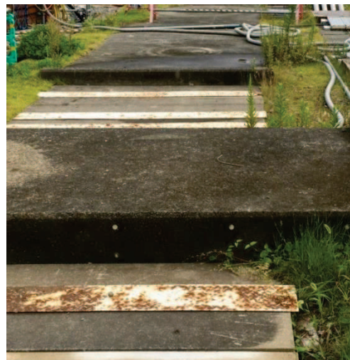
南側幹線排水路 (写真2)
