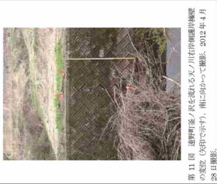
第11図 湯野町釜ノ沢を流れる天ノ川右岸細断層崖壁の変位(矢印で示す)。南に向かって撮影。2012年4月28日撮影。
