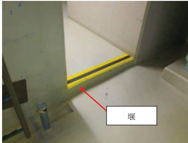
図 4-1 漏えい油の拡大防止対策の例
