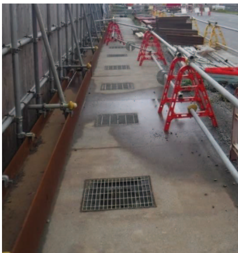
北側幹線排水路 (写真1)
