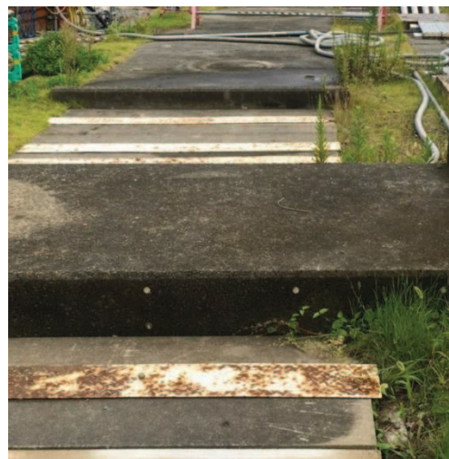
南側幹線排水路 (写真2)
