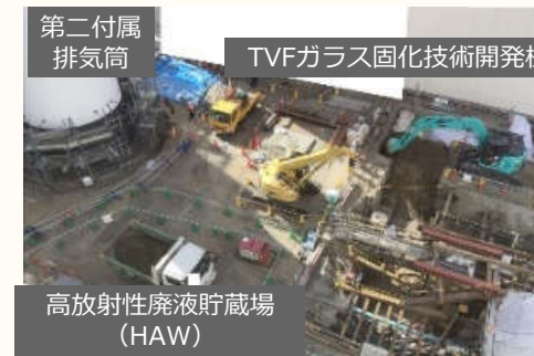
安全性向上対策 (HAW周辺地盤改良工事の状況)
